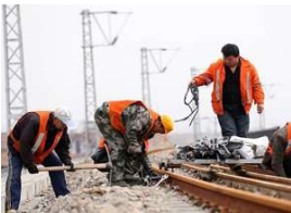
黄韩侯铁路侯西段电气化复线施工
